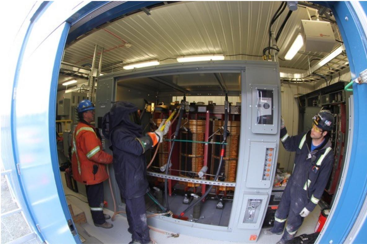
Figure 9 – Installation de l'appareillage de connexion et de l'électronique de puissance
